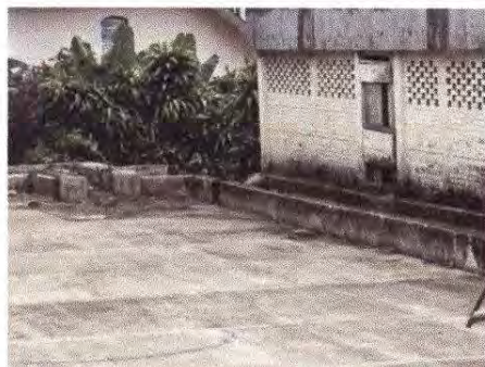
Foto 33: 16.1. Reparación de planchas de concreto de patio
