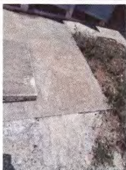
Foto 27: 6.1. Reparación de piso de torta de concreto
