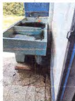
Foto 24: 20.10. Sustitución de pila de cemento de dos lavaderos
