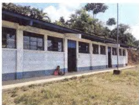
Foto 11: 7.1. Sustitución de canal de metal
