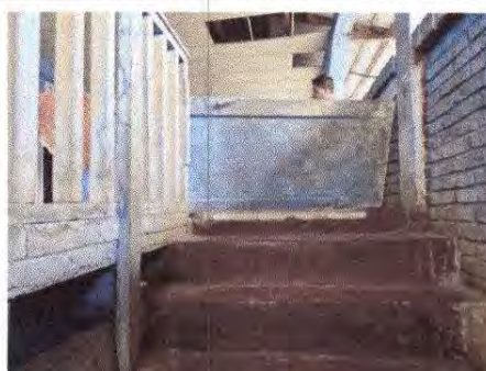
Foto 8: 11.2. Sustitución de barandas de madera por barandas de metal
