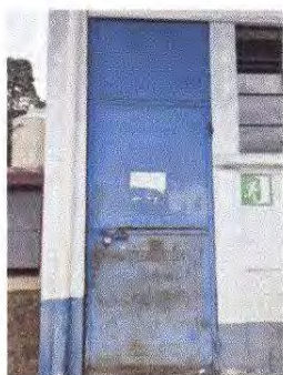
Foto 9: 4.1. Mantenimiento a estructura (lijado, cepillado y aplicación de pintura)
