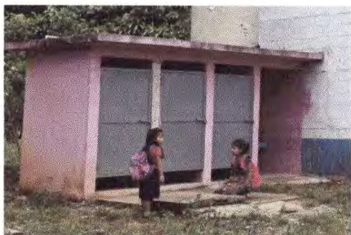
Foto 29: 9.1. Pintura en muros exteriores e interiores
