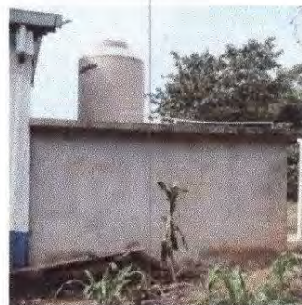
Foto 28: 9.1. Pintura en muros exteriores e interiores
