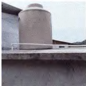
Foto 31: 14.11. Sustitución de llave de cheque
