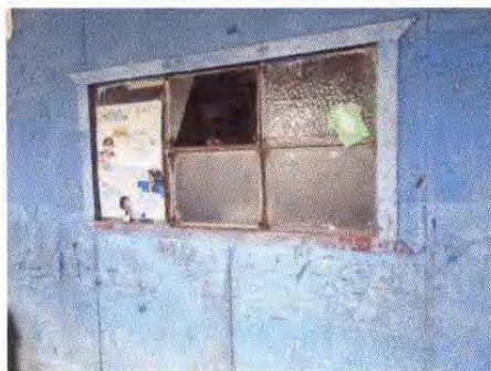
Foto 1: 5.5. Sustitución de vidrios
