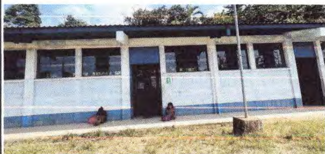
Foto 13: 9.1. Pintura en muros exteriores e interiores
