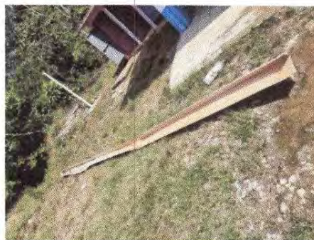
Foto 10: 7.1. Sustitución de canal de metal por canal de metal
