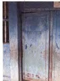
Foto 2: Reparación de puerta de madera (cambio de visagras, pasador, lijado, colocación de pintura)
