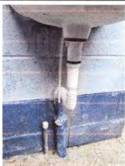
Foto 21: Sustitución de contrallave en lavamanos e inodoros
