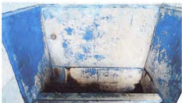
Foto 25: 21.4. Sellado de grietas y fisuras en muro
