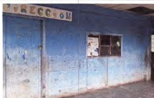
Foto 4: Reparación de pared de cartoncillo por pared de tablayeso
