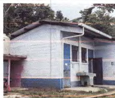
Foto 16: 9.1. Pintura en muros exteriores e interiores
