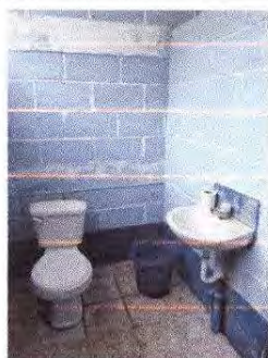
Foto 17: 9.1. Pintura en muros exteriores e interiores
