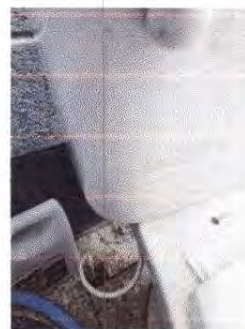
Foto 22: Sustitución de contrallave en lavamanos e inodoros
