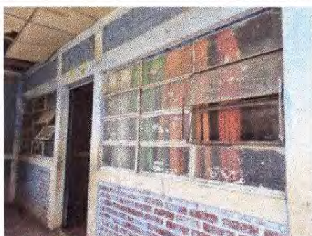
Foto 5: 5.5. Sustitución de vidrios
