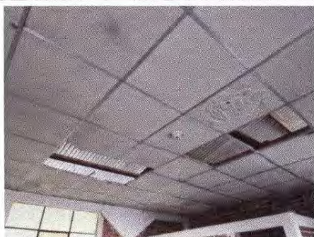
Foto 3: Sustitución cielo falso
