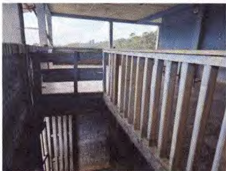
Foto 7: 11.2. Sustitución de barandas de metal
